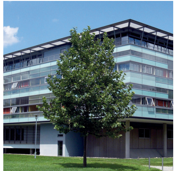
Dienststelle Schweinfurt in der Gunnar-Wester-Straße 6
